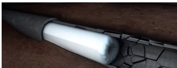
Figura 9 – Inserção pelo método CIPP Fonte: Tstrenchless (2015)
