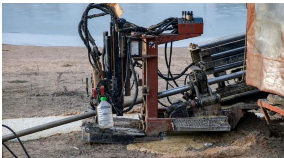
Figura 6 – Tracionador hidráulico Fonte: Ustrenchless (2021)
