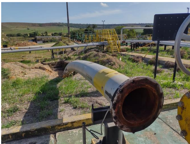
Figura 14 – Chegada do duto na estação recebedora Fonte: Própria (2022)
