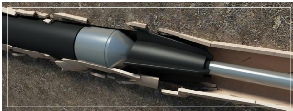
Figura 3 – Pipe Bursting Fonte: Tstrenchless (2015)
